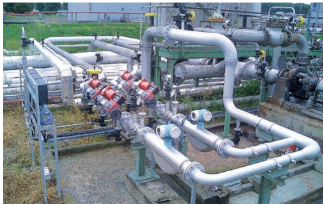
Obr. 5 Jedna z 30 miešacích staníc s iskrovo bezpečnými prevádzkovými meracími prístrojmi
