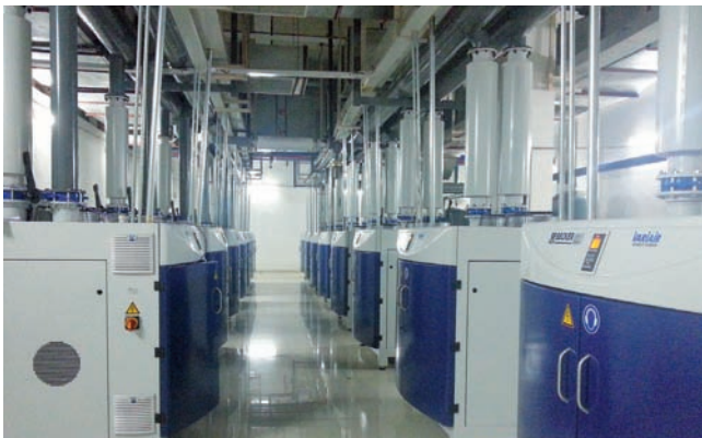
Centrálny systém dodávky vzduchu zabezpečuje odsávanie a fúkanie vzduchu pre niekoľko výrobných liniek energeticky účinným spôsobom.
